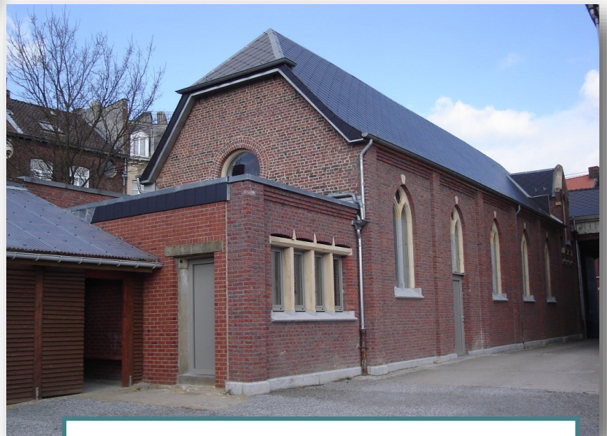
Bâtiment « la Chapelle »
